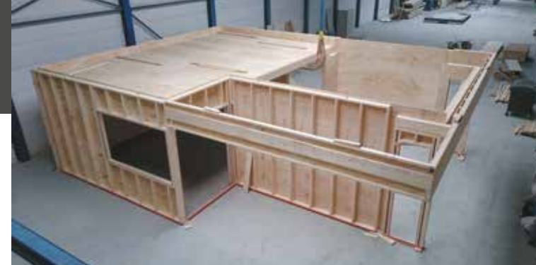
Productie prefab opbouw in eigen fabriek
